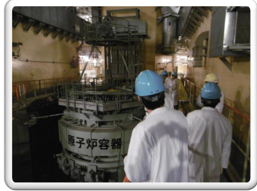
(格納容器オペレーションフロア から原子炉容器を臨む)
