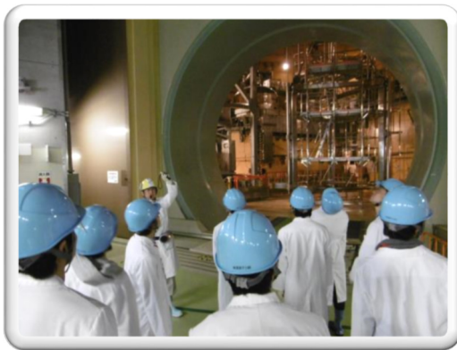
(原子炉格納容器内)
