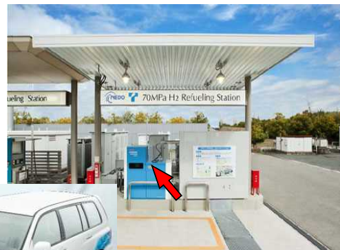
水素ステーション
